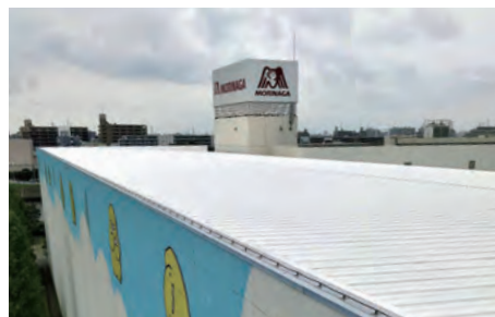
鶴見工場 製品倉庫屋根の遮熱塗装
