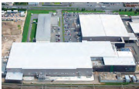
高崎森永株式会社 第三工場
